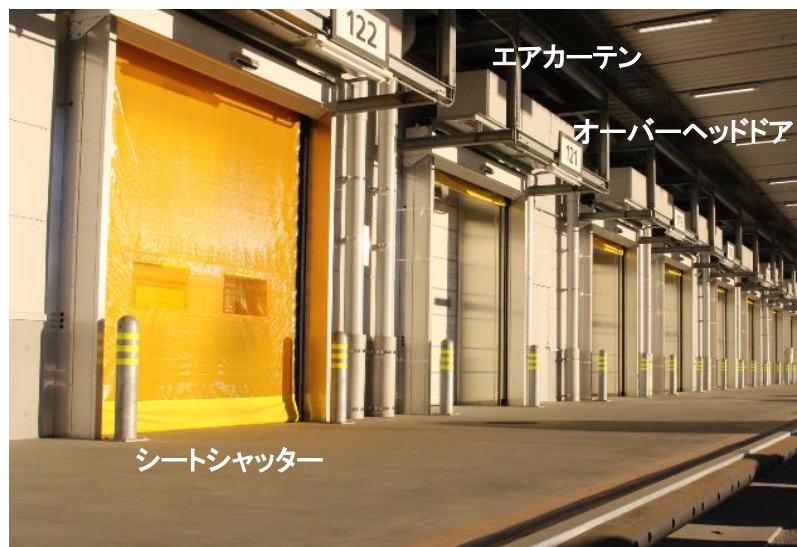
図 8 トラックバースのシートシャッター、オーバーヘッドドア、エアカーテンの整備
