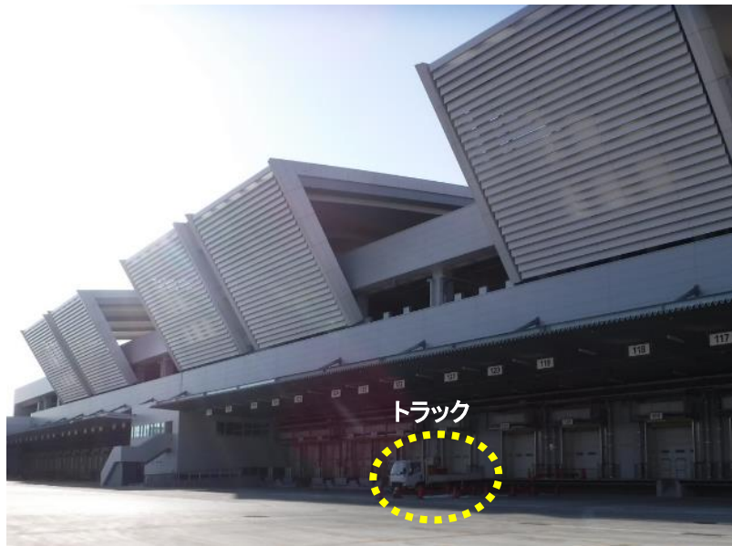
図 7 水産卸売場棟の搬入車両が停車するバース
