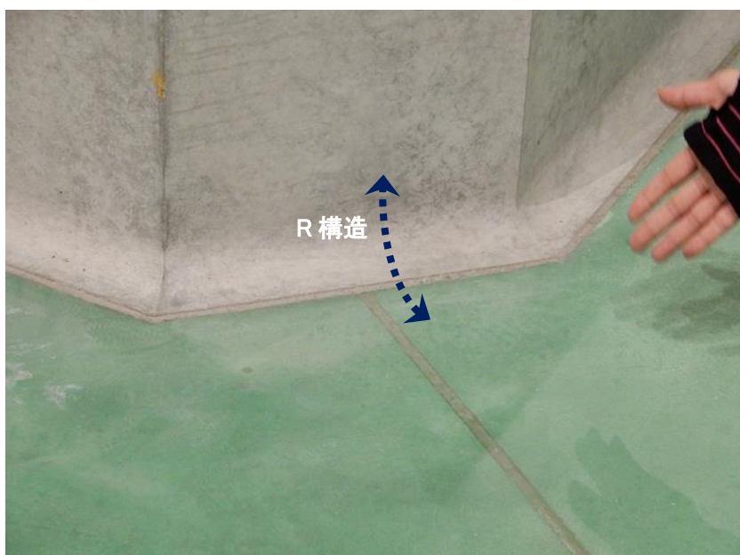
図 11 床接合部分の R 構造
